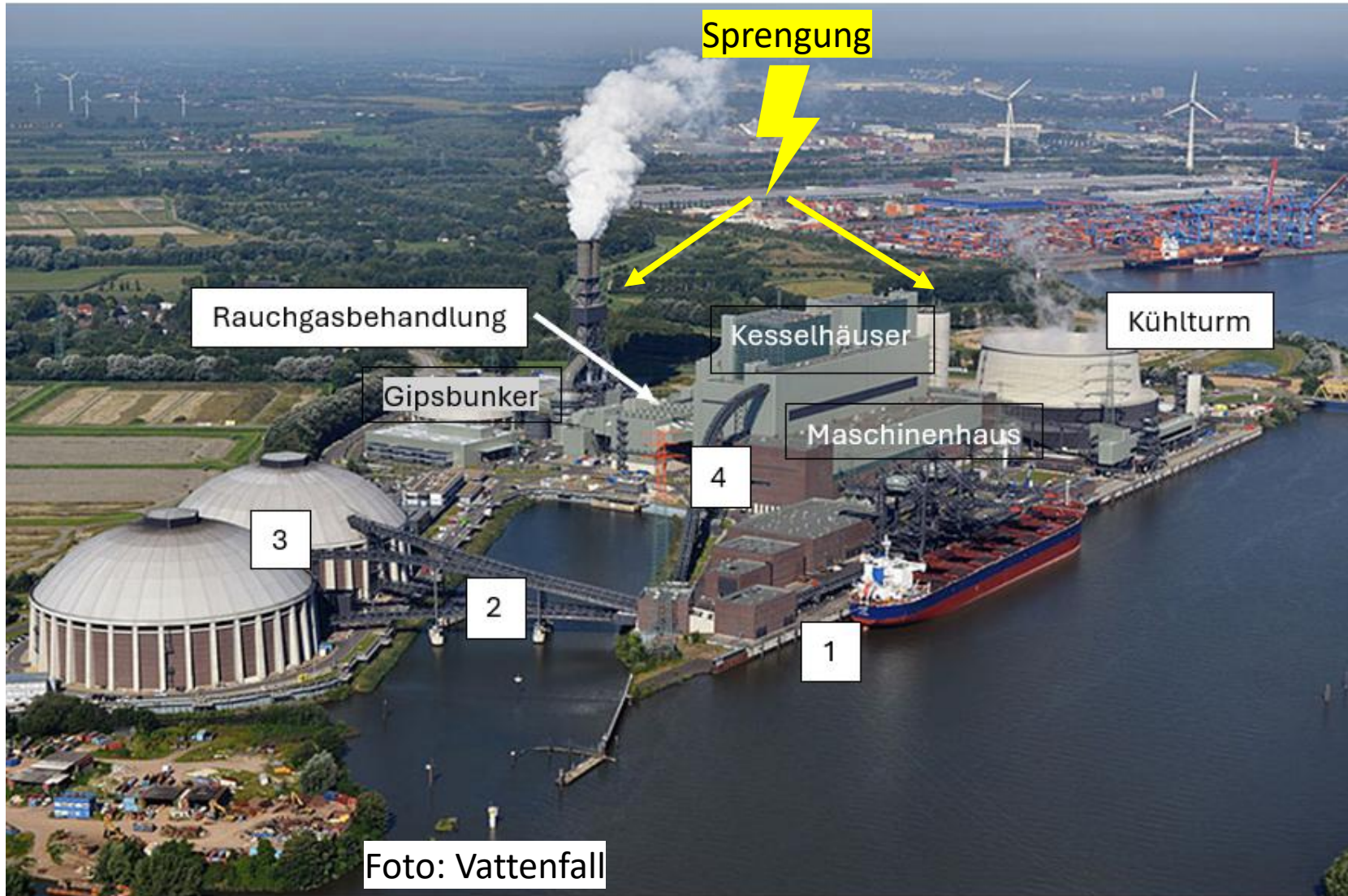
Steinkohlekraftwerk Moorburg von 2015 – 2021 abgestellt wegen Kohleausstieg
